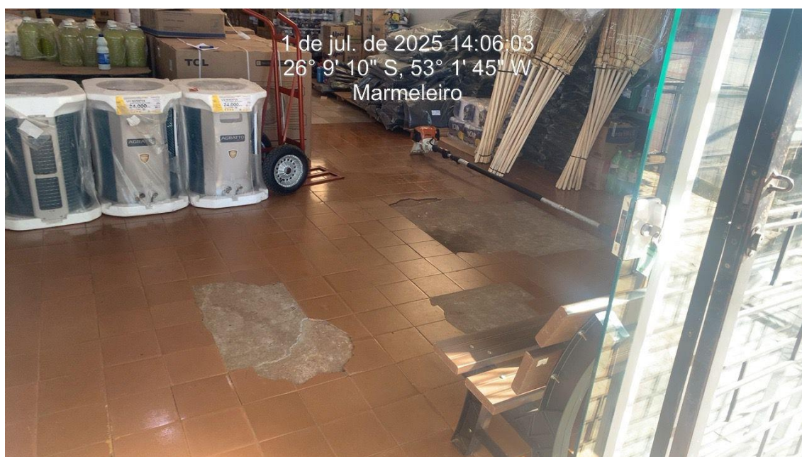
Figura 2 – Pisos quebrados e irregulares.
