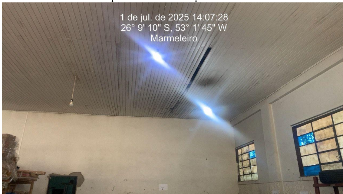
Figura 6 – Forro deteriorado, com vários indícios de infiltração na cobertura, alguns locais apresentam risco de colapso do forro.
