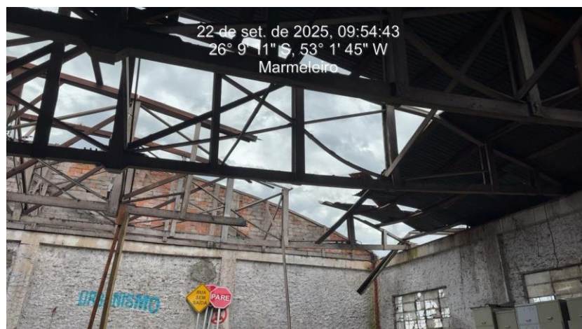
Figura 1 – Tesouras comprometidas estruturalmente.
