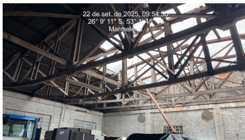
Figura 2 – Telhado colapsado.
