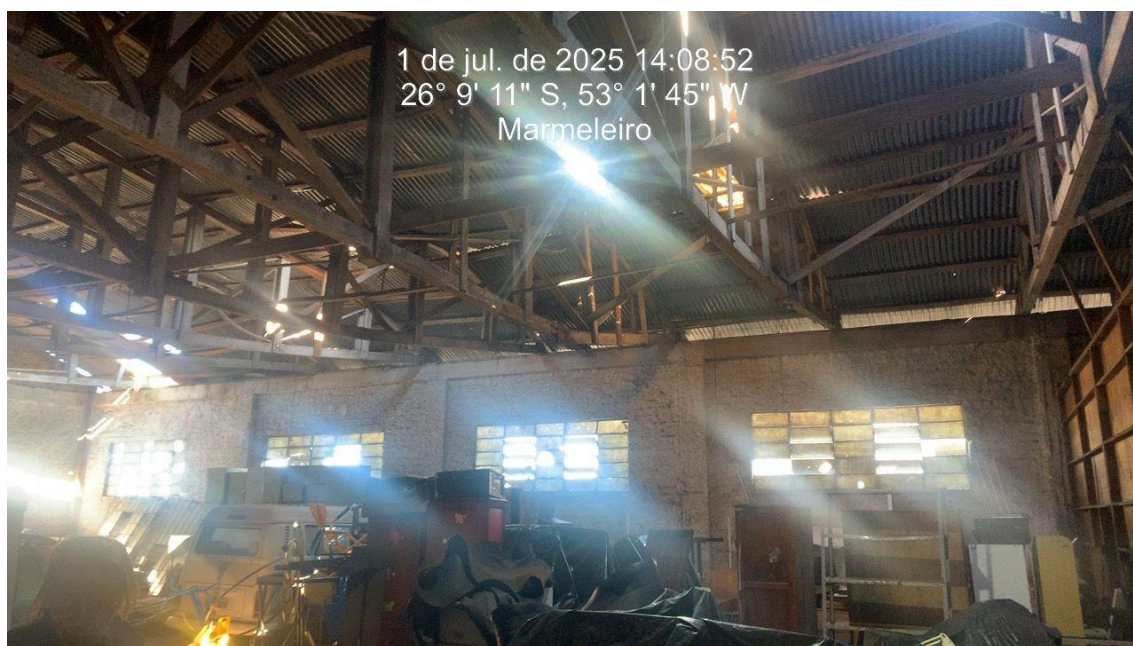
Figura 11 – Estruturas de tesouras em madeira com grande deformação.
