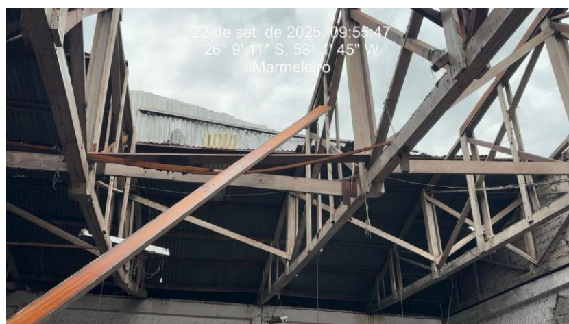
Figura 4 – telhado colapsado.
