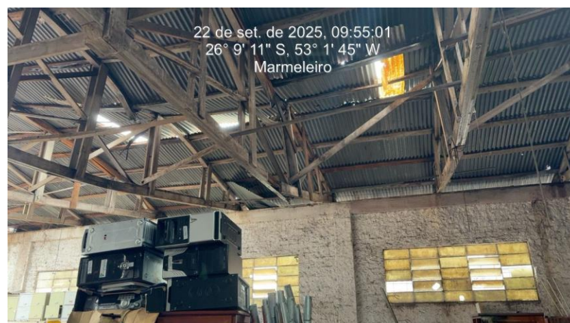
Figura 6 – Tesouras na iminência de colapso.
