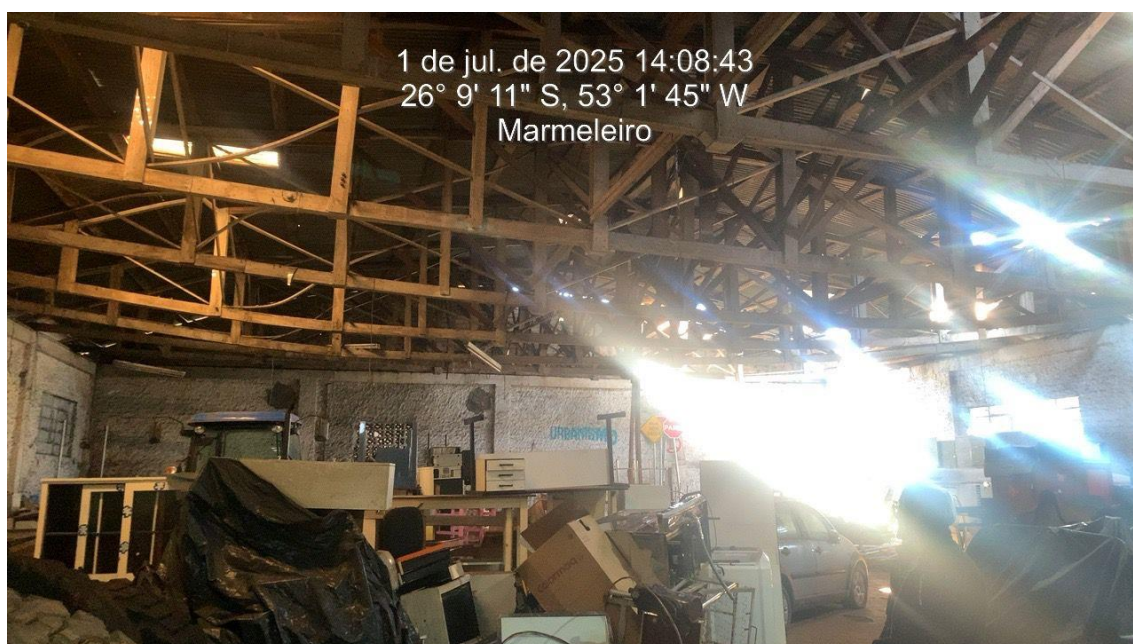
Figura 10 – Estruturas de tesouras em madeira com grande deformação.
