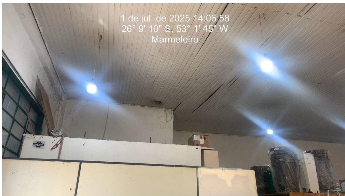
Figura 3 – Forro deteriorado, com vários indícios de infiltração na cobertura, alguns locais apresentam risco de colapso do forro.
