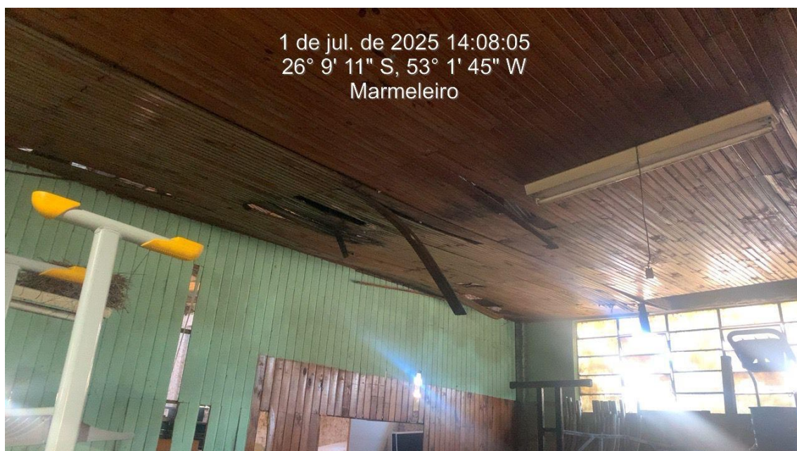
Figura 7 – Forro deteriorado, com vários indícios de infiltração na cobertura, alguns locais apresentam risco de colapso do forro.
