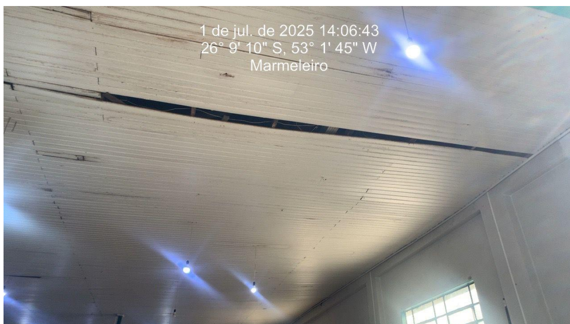
Figura 4 – Forro deteriorado, com vários indícios de infiltração na cobertura, alguns locais apresentam risco de colapso do forro.
