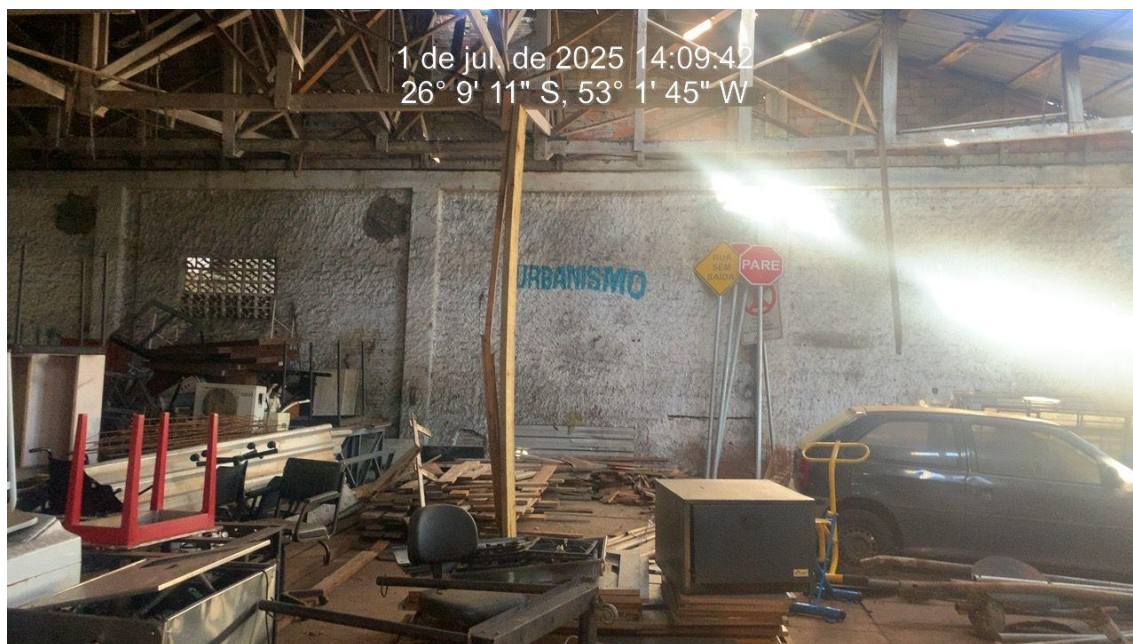
Figura 16 – Estruturas de tesouras em madeira quebradas com ausência de parte da estrutura, escoradas provisoriamente e risco iminente de colapso.
