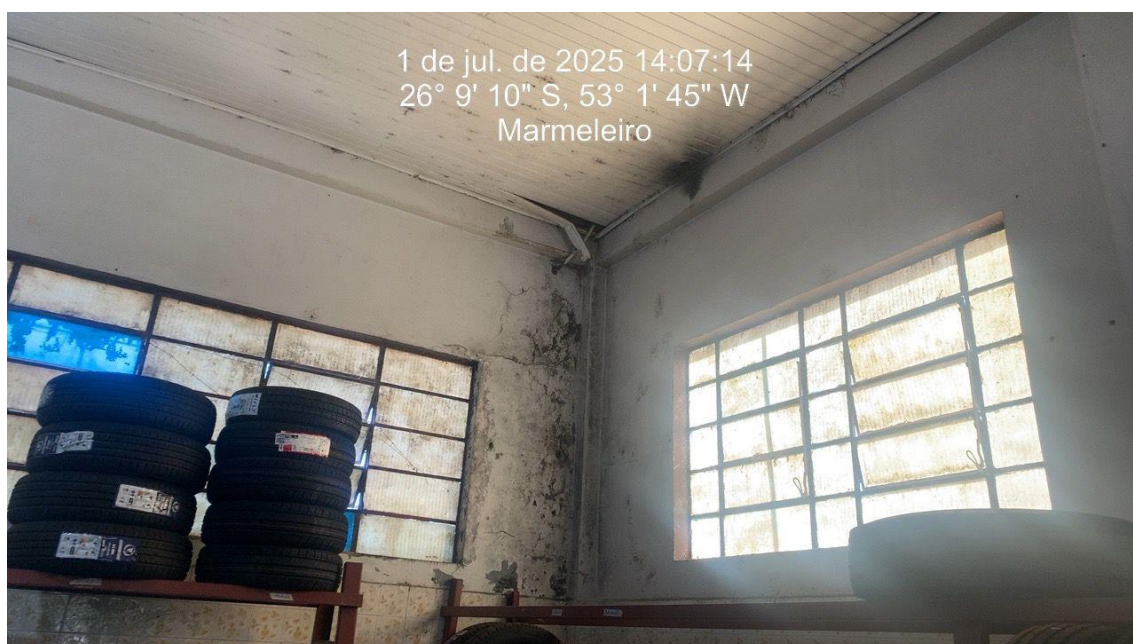
Figura 5 – Paredes com mofo, umidade ascendente e de infiltração da cobertura.
