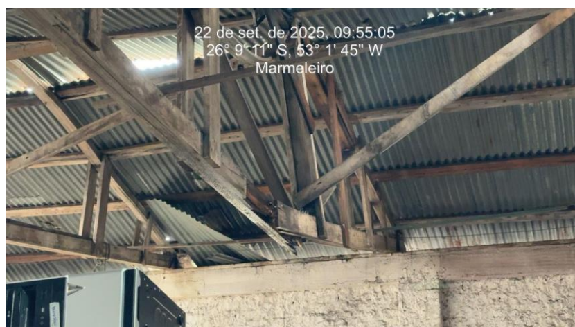
Figura 3 – Estrutura das tesouras condenadas.
