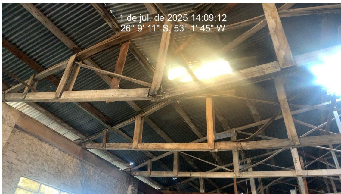
Figura 15 – Estruturas de tesouras em madeira com rachaduras e risco iminente de colapso.
