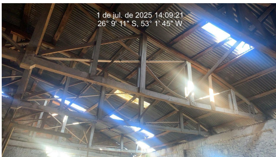
Figura 13 – Estruturas de tesouras em madeira com grande deformação.
